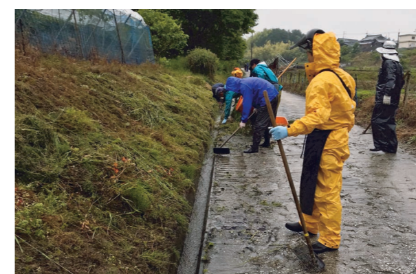
水路清掃(総合研究所; 2020年5月)
