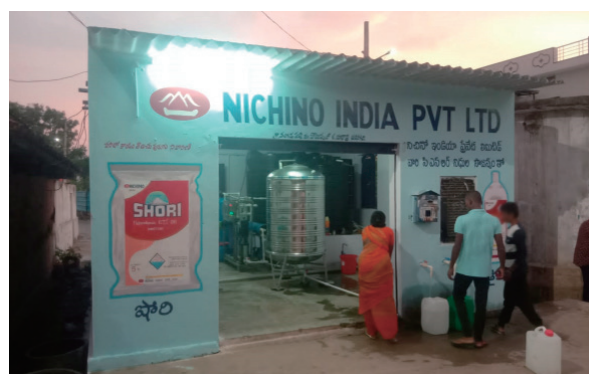
給水スポットの様子
