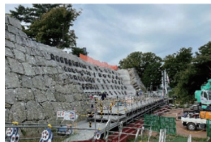
修復工事現場
