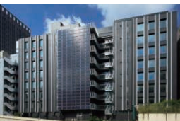
本社(東京・京橋)
